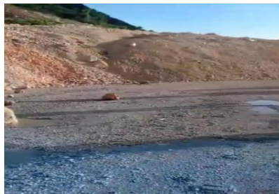
Vista panorámica de los deslizamientos de tierra del tramo carretero La Ciénega, provincia Barahona
