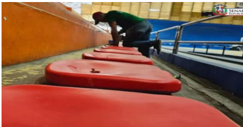
Vista de gradas del Polideportivo de San Cristóbal
