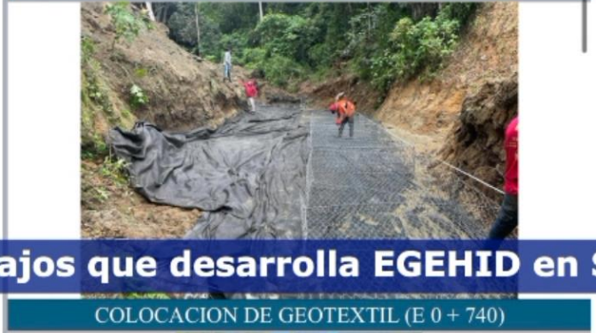
Imágenes de los trabajos que desarrolla la EGEHID en Santiago.
