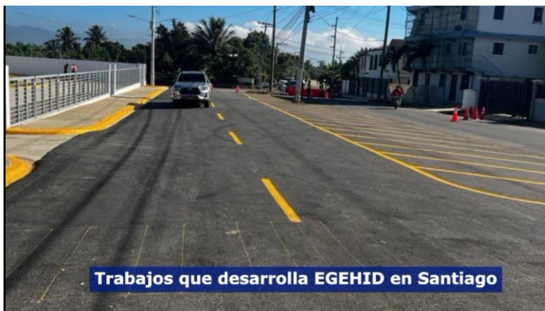
Imágenes de los trabajos que desarrolla la EGEHID en Santiago.
