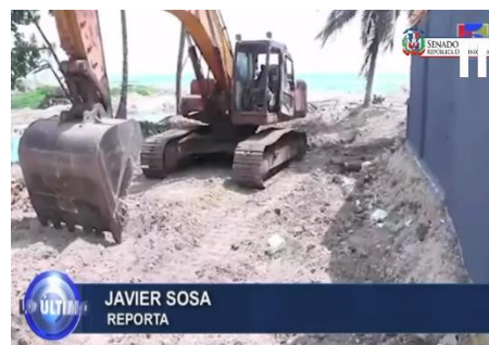
Vista panorámica de la de la construcción del malecón de la provincia María Trinidad Sánchez.
