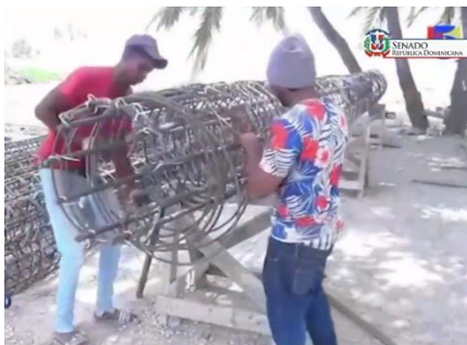
Trabajadores en las labores de la construcción del malecón de la provincia María Trinidad Sánchez.
