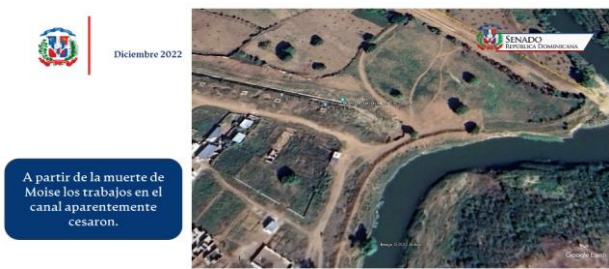
Vista satelital del territorio de Haití donde se construye el canal
