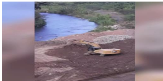
Pala mecánica en un río de la provincia San José de Ocoa
