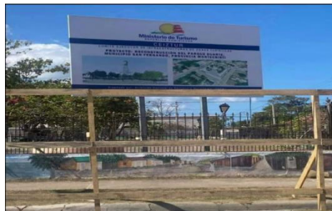
Proyecto reconstrucción parque Duarte.
