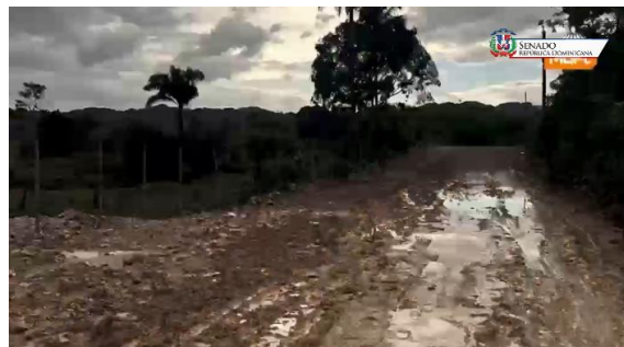
Estado anterior de la carretera Hato San Pedro-Rincón Claro
