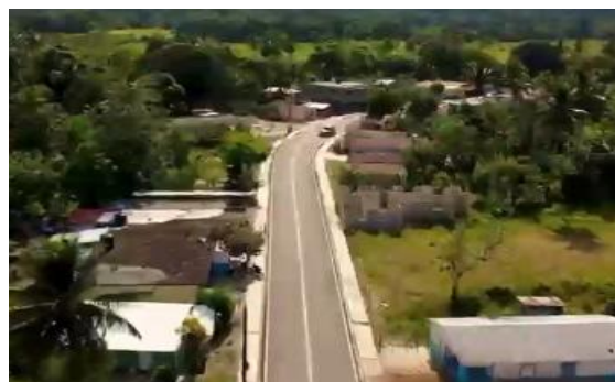
Estado actual de la carretera Hato San Pedro-Rincón Claro
