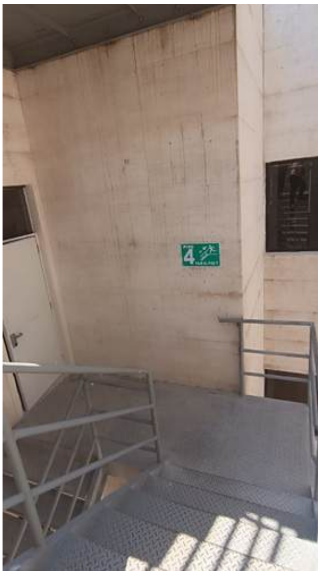
Señalética escalera de emergencia
