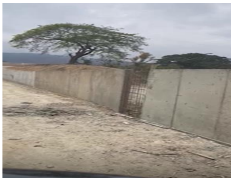
Vista panorámica del muro perimetral.
