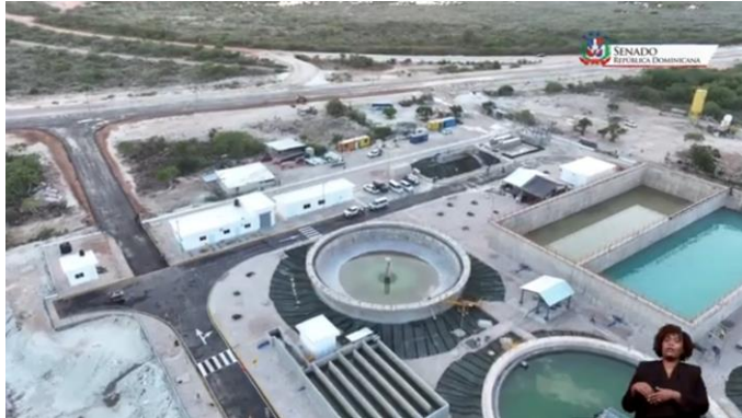
Imagen de la Planta de tratamiento en Cabo Rojo, Pedernales.
