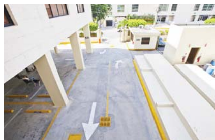
Entrada vehicular parqueo senadores y funcionarios
