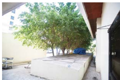
Puerta de Carga – Primer Piso
