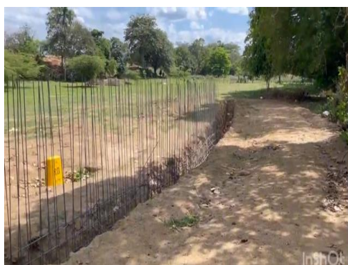
Parte de la construcción del muro fronterizo entre República Dominicana y Haití
