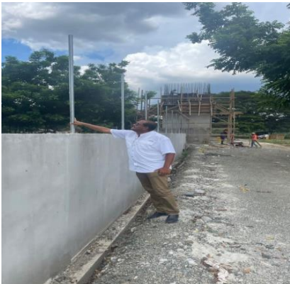
El senador David Rafael Sosa Cerda, indica la calidad de materiales utilizados en la construcción del muro fronterizo dominico-haitiano, en la provincia Dajabón.
