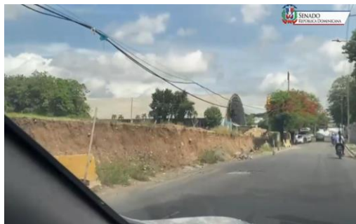
Vista de la pared de la cancha de fútbol Rosendo Tavárez, San Cristóbal
