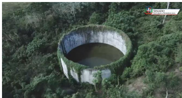
Vista panorámica del acueducto, provincia Monte Plata, el antes
