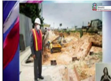
Construcción del edificio Juan Pablo Duarte, del Tribunal Constitucional
