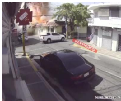
Una cámara de seguridad captura el momento en que ocurre la explosión en San Cristóbal
