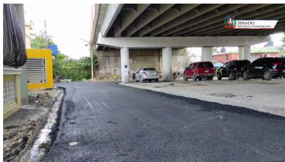
Construcción de la carretera que conecta el puerto con Hato Mayor y Monte Plata.
