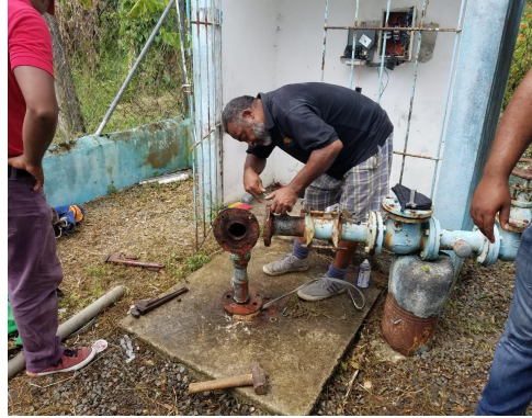
Instalación de bomba sumergible en la Meseta de El Cuey 30-10-2018
