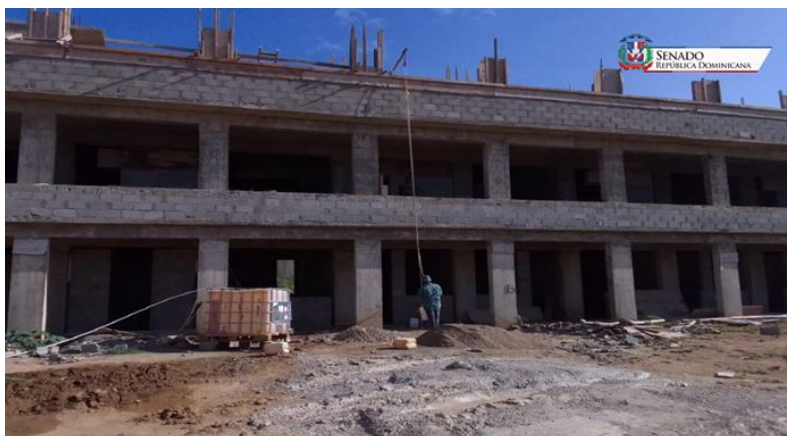
Vista frontal de un plantel escolar en construcción
